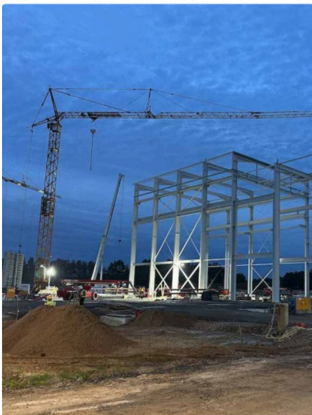
1400 Tonnen Stahlträger aus CO 2 -reduziertem Sekundärstahl für einen neuen nachhaltigen Standort
