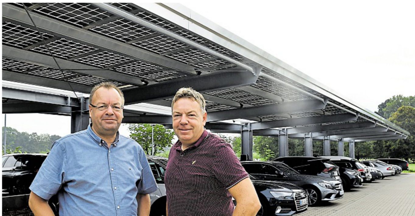
Michael (links) und Thomas Wurst haben auf ihrem Firmengelände die PV-Carports als Musteranlage aufgestellt. Zehn Prozent des Stroms, den das Unternehmen benötigt, werden so produziert.
